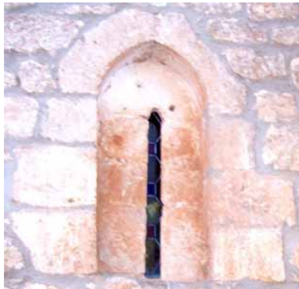
Ventana del ábside desde el exterior
